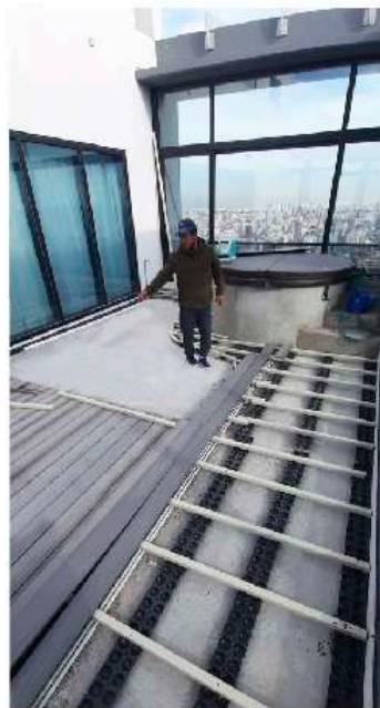
Figura A / Proceso instalación deck
