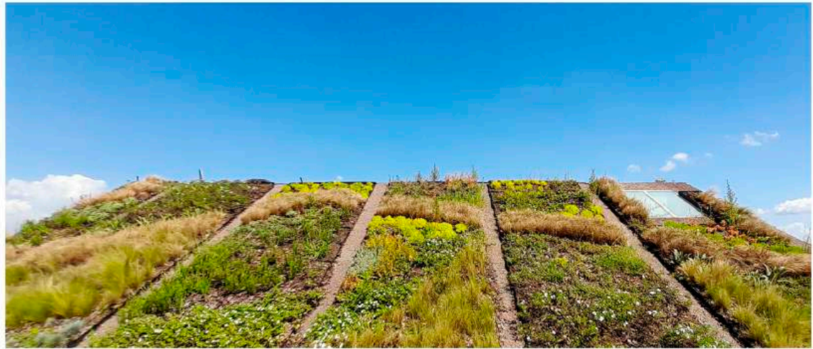
Figura B / Terraza verde realizada en conjunto con @paisajismotomasnadares y @algan_arquitectos
