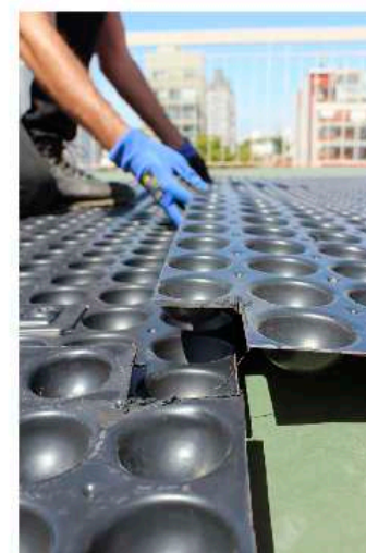
Figura D / Encastre entre placas
