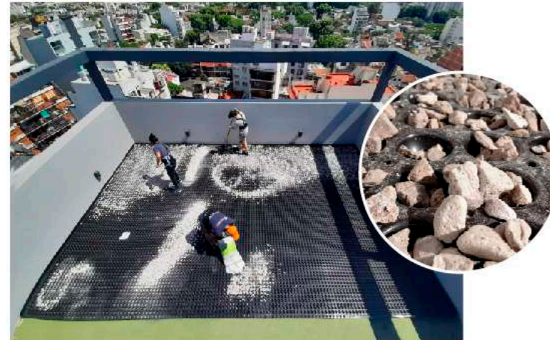
Figura A / Esparcido de pometina en toda el área
