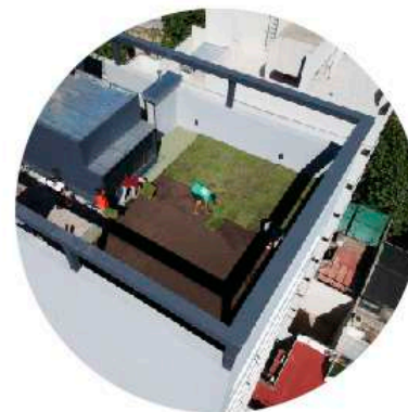
Figura C / Colocación de césped
